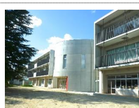
南から見た校舎
