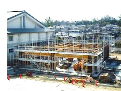
↑ 建設中の新校舎
